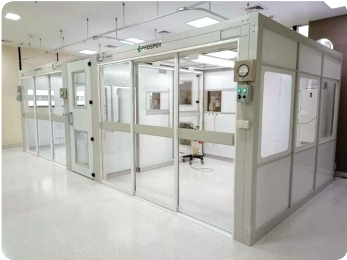
รูปที่ 16 ห้อง Negative pressure แบบดัดแปลง (Modified)
